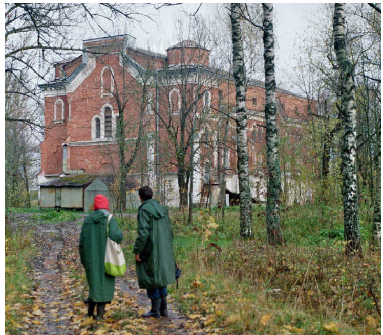
Institutsgebäude von Pawlowsk
